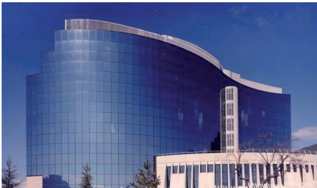
Palazzo Silone, sede della regione, a L'Aquila
